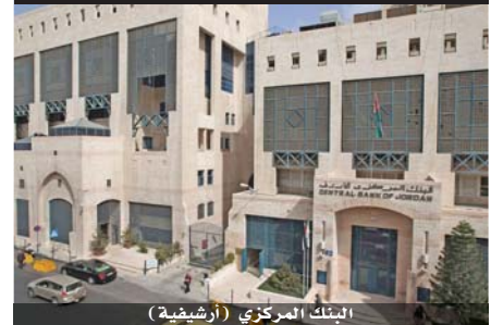
البنك المركزي (أرضيضية)
