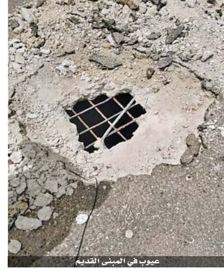
عيوب في المبنى القديم
