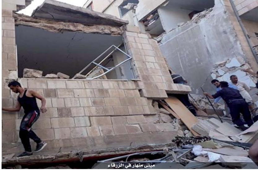
مبنى منهار في الزرقاء
