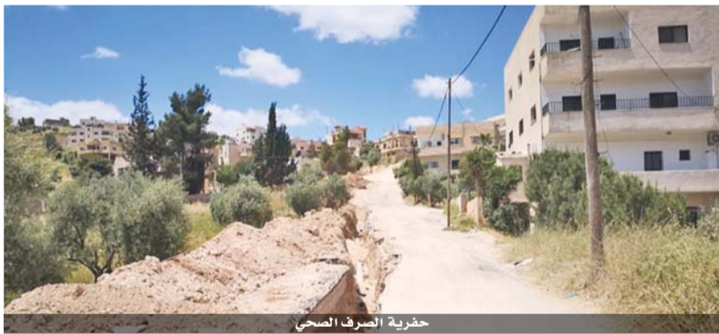
حفريات الصرف الصحي
