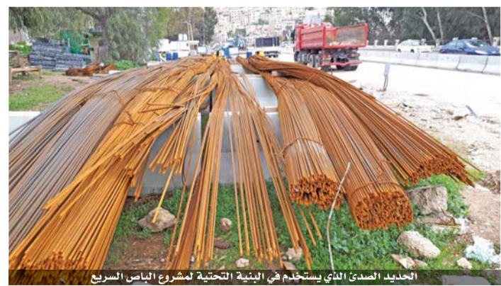
الحديد الصدئ الذي يستخدم في البنية التحتية لمشروع الباص السريع
