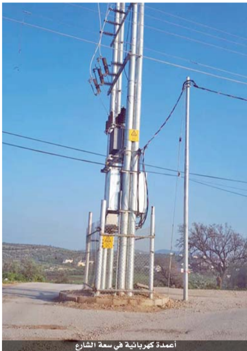
أعمدة كهربائية في سعة الشارع
