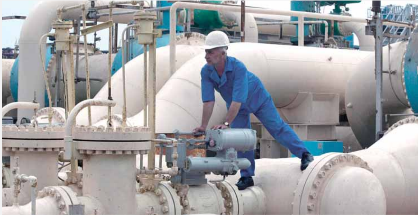
محطة البصرة للنفط
